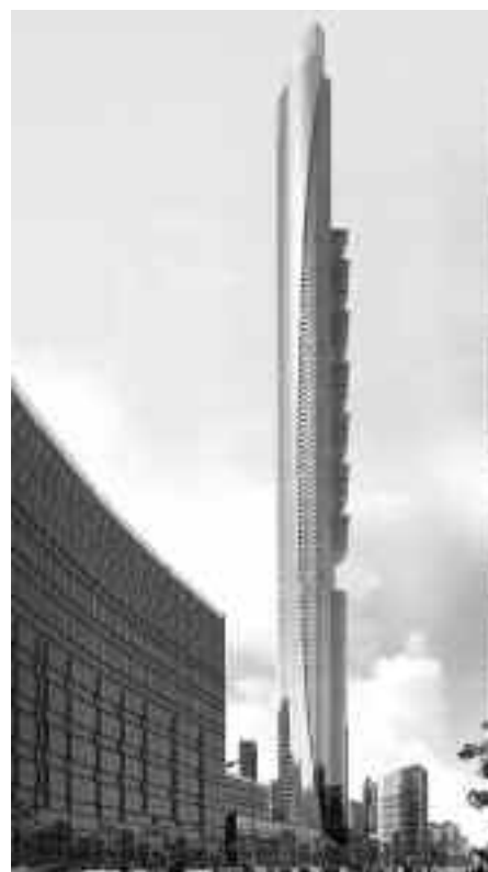
Fot. 9. Pentominium Tower w Dubaju wysokości 516 m (www.pentominium.com)
