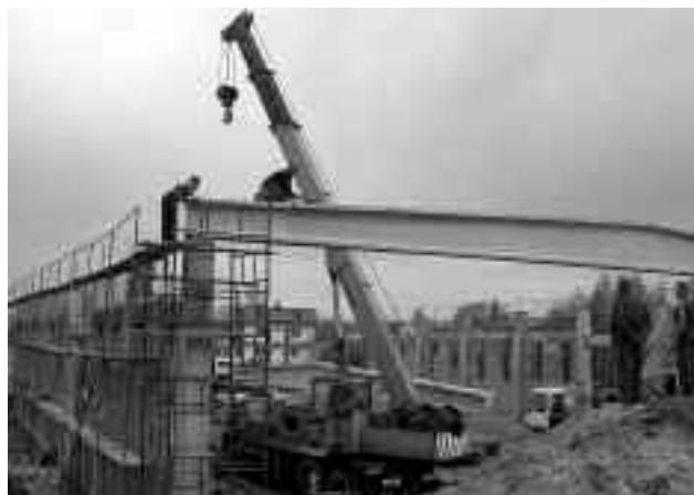
Montaż dźwigara strunobetonowego (długość 26 m)
