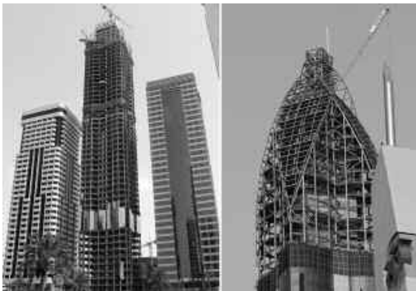
Fot. 3. Rose Rotana Hotel – konstrukcja budynku (www.burijdubaiskyscrapers.com)
