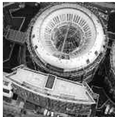
Fot. 3. Gazometr B – widok z góry [www.wiener-gasometer.at/de]
