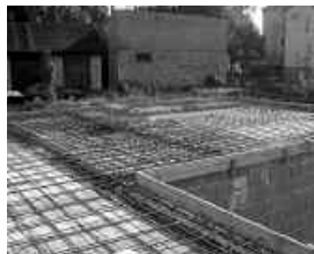
Fot. 1. Płytowy żelbetowy strop monolityczny przed betonowaniem Fot. autor
