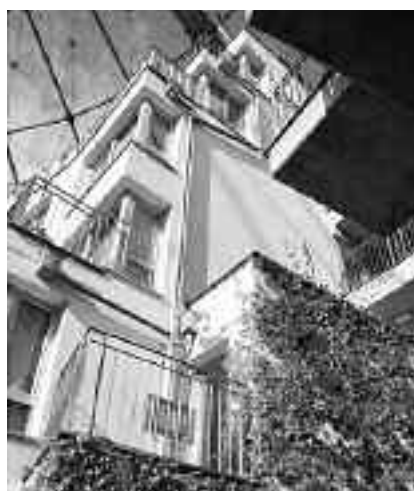
Fot. 4. Gazometr C – wnętrze budynku [www.wiener-gasometer.at/de]
