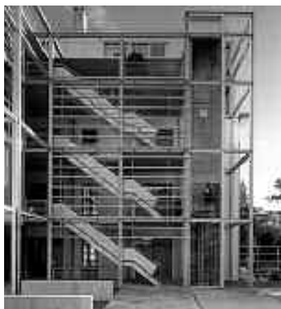
Fot. 8. Konstrukcja stalowa zewnętrznych klatek schodowych
