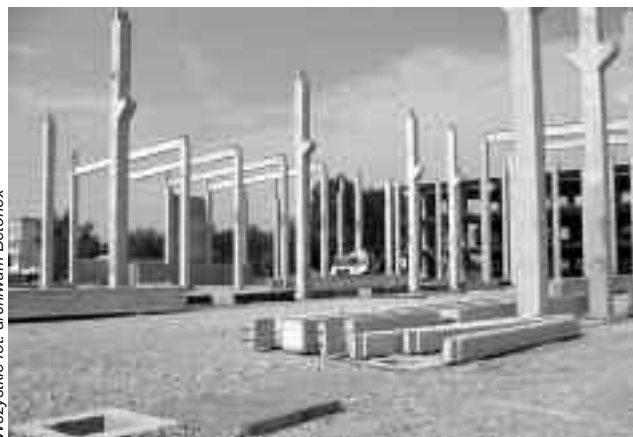
Słupy prefabrykowane hali w Tychach
