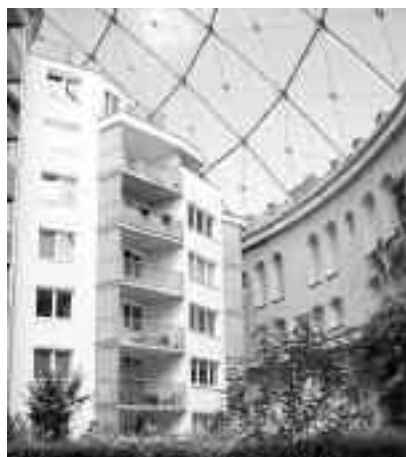
Fot. 5. Gazometr D – atria wewnętrzne, część mieszkalna
