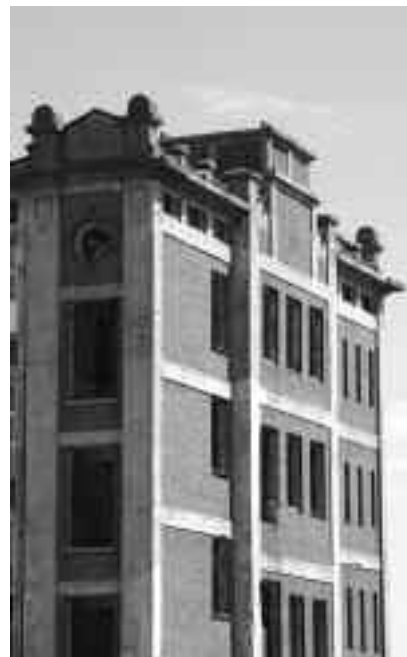
Wyremontowana elewacja Nowej Przędzalni
