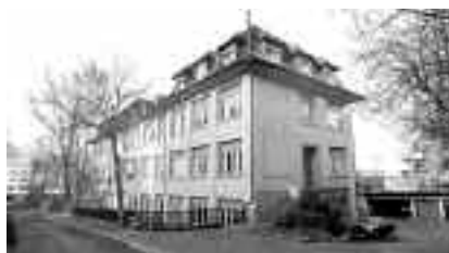
Fot. 6. Stara fabryka mydła i detergentów w Zurychu [Kugel C. „Soap Opera – architectural design” – Architectural Review, November 1999]
