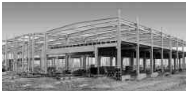
Konstrukcja centrum logistycznego k. Grójca
