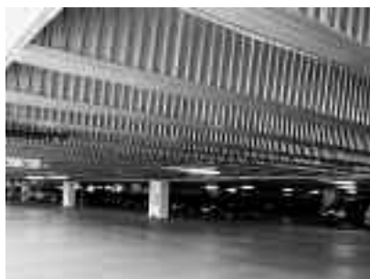
Fot. 4. Strop Swedeck Fot. archiwum Biuro Konsultingowe Swedeck
