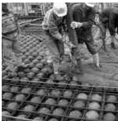
Fot. 3. Prefabrykowane zbrojenie i betonowanie stropu Cobiax [www.baumat.com.pl]
