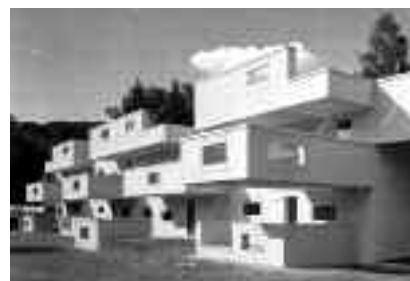
Fot. 3. Budynek mieszkalny w Gratkorn w Austrii ( http://www.nextroom.at/building_article.php?building_id=242&article_id=3234 )
