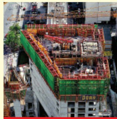
Fot. 1. System samoczynnego wspinania ACS przy realizacji hotelu Inter-Continental w Warszawie
