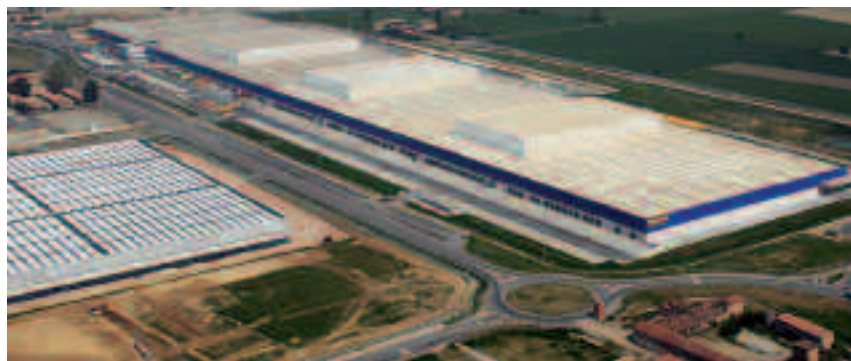
IKEA, PIACENZA WŁOCHY. Zastosowano 200 tys. m 2 membrany TPO FLAGON EP/PR
