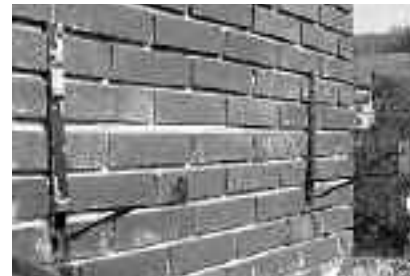
Fot. 10. Wsporniki płotka przymocowane do komina jako podpory pod ławę kominiarską
