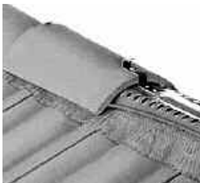
Fot. 2. Prawidłowy montaż klamer
