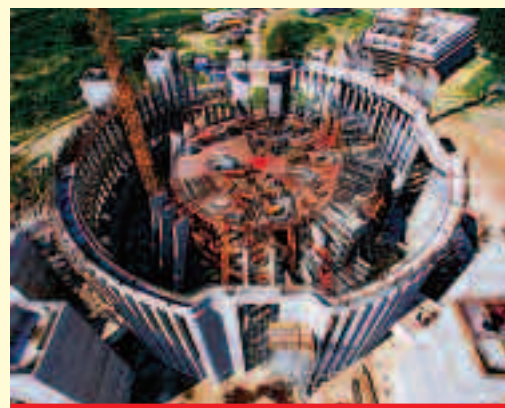
Fot. 3. Widok z góry na budowę Świątyni Świętej Opatrzności Bożej
