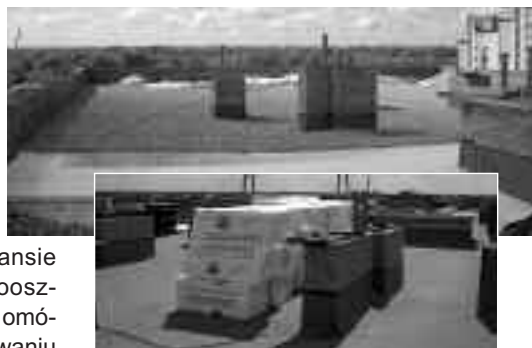
Stropodach ocieplony płytami Steinodur® PSN LD
