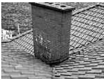
Fot. 6. Błędne zaprojektowanie usytuowania komina
