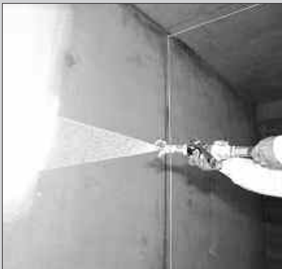
Mechaniczny natrysk Gładzi gipsowej
