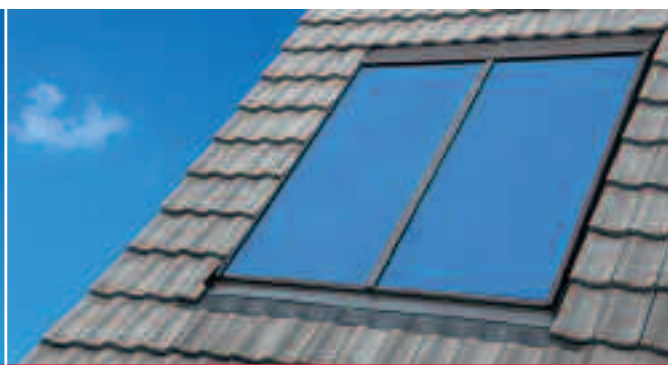
Kolektory słoneczne – przykład połączenia poziomego
