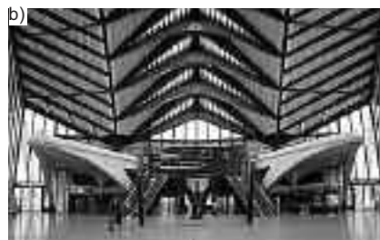
Fot. 7. Dworzec Satolas TGV: a – widok ogólny; b – główna poczekalnia w konstrukcji stalowej
