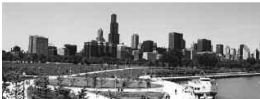
Fot. 2. Ekspozycja budynku Sears Tower w Chicago
