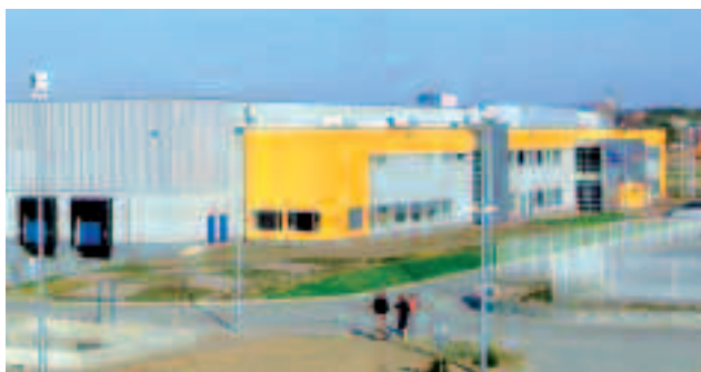
Fot. 1. Pentair-Schroff – Dzierżonów; w tym obiekcie zastosowano dodatkowo wkładki akustyczne
