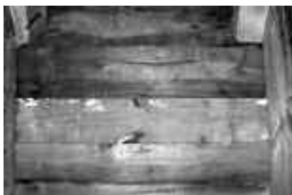
Fot. 2. Deski mogą wchłonąć bardzo duże ilości wilgoci ze skroplin powstających w zimnych okresach roku. Ich wada polega na tym, że tych skroplin na ogół nie widać. Dopiero grzyby i pleśń pokazują problem.
