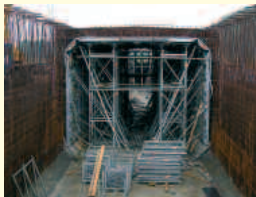
Autostrada A-1; deskowania MD-465 i PD-475A
