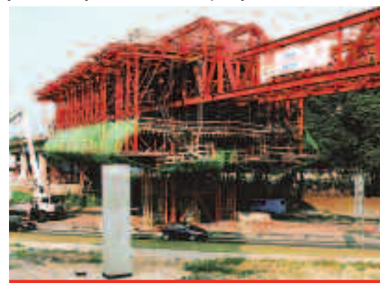
Fot. 2. Uniwersalne urządzenie formujące wiadukt w ciągu DTŚ w Katowicach
