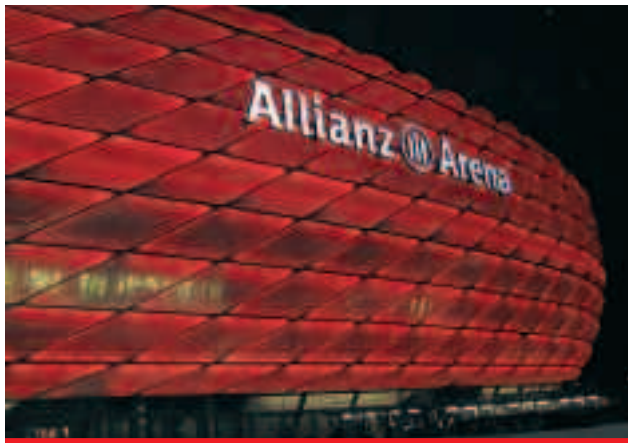
Obiekt sportowy Allianz – Arena w Monachium
