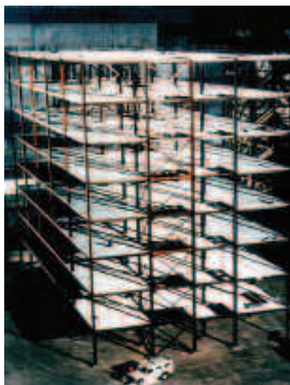
Fot. 1. Ośmiopiętrowy budynek testowy w Cardington przed wylaniem stropów (1997)
