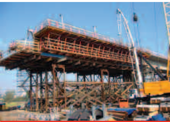
Fot. 1. Stanowisko do nasuwania w ciągu przeprawy przez Wartę w Koninie – estakada E5
