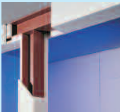
Obudowa konstrukcji stalowej K 252 i K 253
