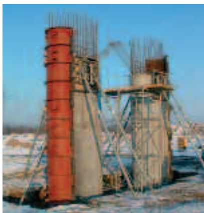
Obwodnica Kobyłanki (DK-10); deskowania WD-2 i WD-3
