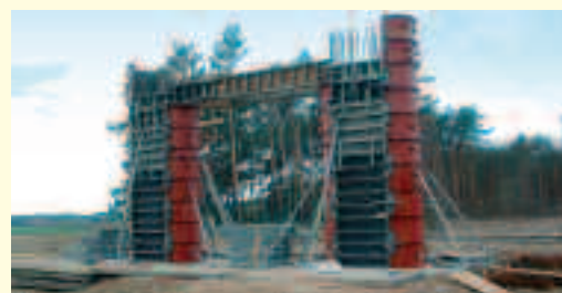
Autostrada A-1; deskowanie WA-470
