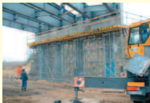
Autostrada A-2; deskowanie WA-160A
