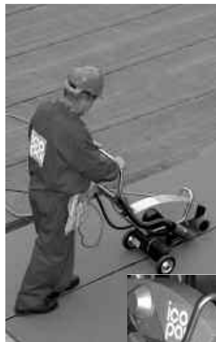
Zgrzewanie papy za pomocą bezpłomieniowego urządzenia FireSmart®
