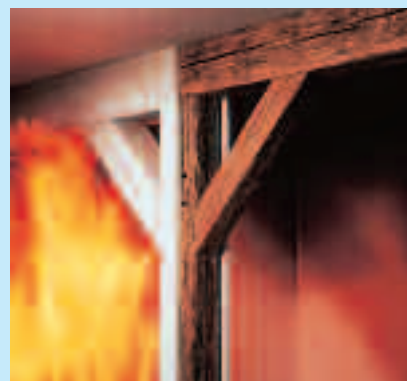
Obudowa konstrukcji drewnianej K 254 i K 255
