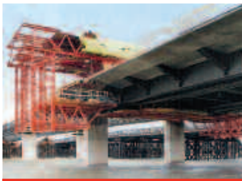
Fot. 3. Widok ogólny urządzenia formującego PERI zastosowanego przy wykonywaniu płyty pomostowej mostu Świętokrzyskiego w Warszawie
