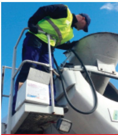
Fot. 2. Dozowanie preparatu RE-CON ZERO bezpośrednio do betonowozu
