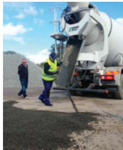
Fot. 3. Rozładunek granulowanego materiału po zastosowaniu preparatu RE-CON ZERO
