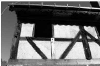
Fot. 2. Ucięty fragment zastrzału. Słup po prawej stronie niewłaściwie oparty na nowej podwalinie za pomocą drewnianej podkładki
