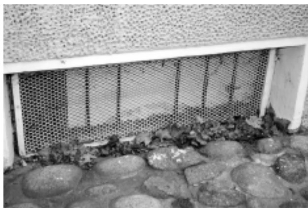
Fot. 3. Okienko piwniczne w skrzydle zachodnim od podwórza – zalegające liście w poziomie parapetu
