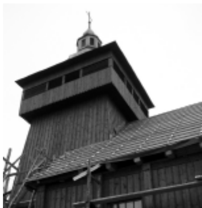
Fot. 1. Wymiana pokrycia dachu w kościele pw. Przemienienia Pańskiego w Kurdwanowie Fot. M. Kapela
