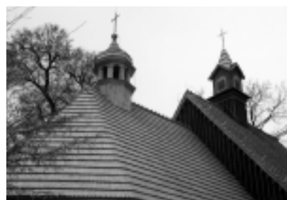
Fot. 5. Dach kościoła w Chotumiu po renowacji Fot. T. Kulas
