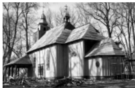
Fot. 4. Wykonywanie prac remontowych kościoła w Drogiszce Fot. T. Kulas
