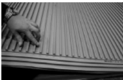
Fot. 8. Przykład wykorzystania powłoki z tworzywa sztucznego w celu eliminacji zagrożeń korozyjnych i poprawy współczynnika przepływu w przepustach betonowych firmy Haba-Beton [17]
