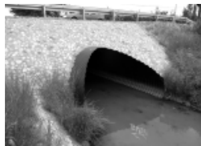
Fot. 7. Przepust z blach falistych z dodatkową powłoką polimerową
