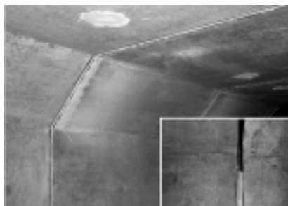
Fot. 3. Przykład zastosowania uszczelki wewnętrznych w przepustach betonowych Fot. A. Wysokowski
