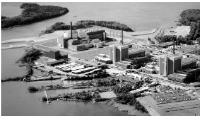
Realizowany obiekt elektrowni jądrowej, Finlandia [3]
