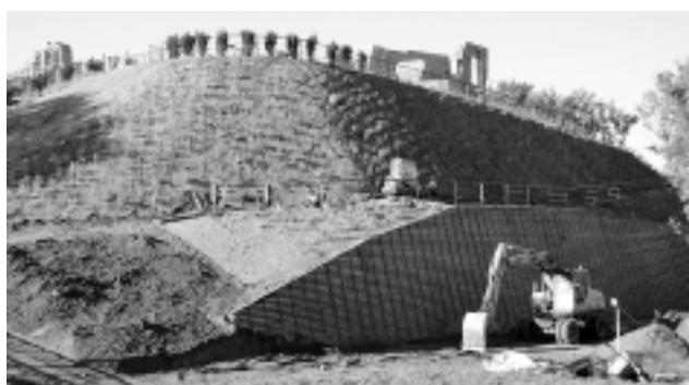
Fot. 4. Widok na kaszycę i wzgórze zamkowe – w czasie prac wykończeniowych
