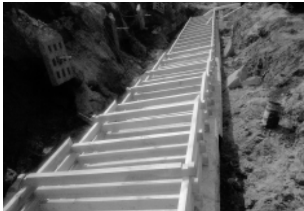
Fot. 2. Układanie warstw elementów kaszycy
