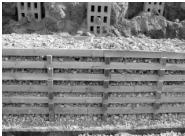
Fot. 3. Zасыпка kruszywem przestrzeni w kaszycy
