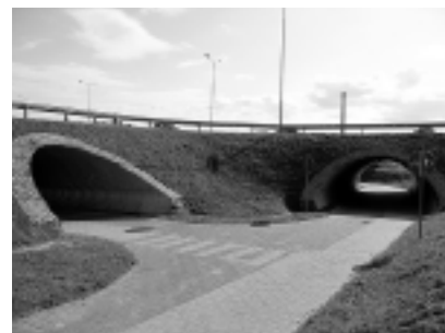
Fot. 3. Wielokierunkowe przejście dla pieszych i rowerzystów wykonane w konstrukcji gruntowo-powłokowej z blach falistych pod drogą kołową w Żaganiu
