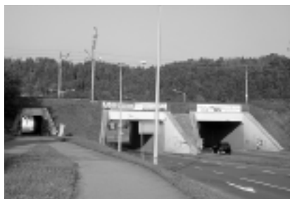
Fot. 4. Widok tuneli drogowych wraz z przejściami dla pieszych i rowerzystów pod liniami kolejowymi (konstrukcje te wykonano jako jedne z pierwszych w kraju metodą przecisku hydraulicznego) – obiekt w Nowym Sączu
