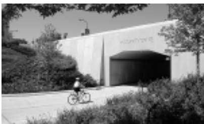
Fot. 2. Estetyczny tunel dla pieszych i rowerzystów w Chicago (USA)
