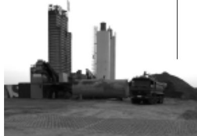
Fot. 1. Ogólny widok stanowiska badawczego na wjeździe na węzeł betoniarski w miejscowości Boczków
