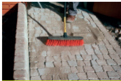
Fot. 5. Układając kostkę brukową, należy pamiętać, aby pomiędzy sąsiadującymi elementami powstawały fugi, które wypełnia się drobnym piaskiem (najlepiej płukanym). Granulacja piasku nie powinna być większa niż 2 mm i należy go wmiatać w spoiny zgodnie z postępowaniem prac
