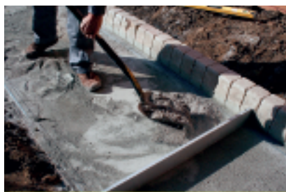
Fot. 3. Mając ułożoną warstwę konstrukcyjną podbudowy oraz oporniki przystępujemy do ułożenia podsypki z odsiewek kamiennych 0 – 4 mm, 0 – 8 mm lub piasku płukanego 0 – 2 mm; grubość tej warstwy po zagęszczeniu powinna wynosić 3 – 5 cm
