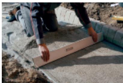
Fot. 4. Warstwę podsypki wyrównujemy łątą, utrzymując odpowiednie spadki i nie zagęszczamy, ponieważ zadaniem tej warstwy jest zapewnienie dobrego osadzenia każdej kostki brukowej oraz zniwelowanie ewentualnej drobnej różnicy wysokości poszczególnych kostek
