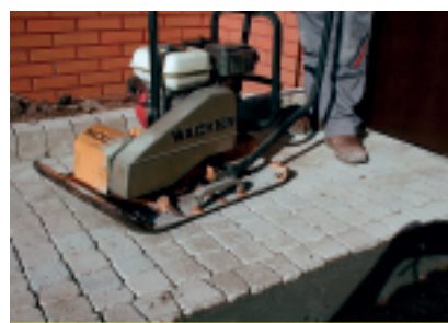
Fot. 6. Prawidłowo ułożoną nawierzchnię z kostki brukowej zagęszcza się za pomocą odpowiedniego wibratora płytowego zabezpieczonego płytą z tworzywa sztucznego, która chroni przed punktowym ścieraniem i wykruszaniem naroży
