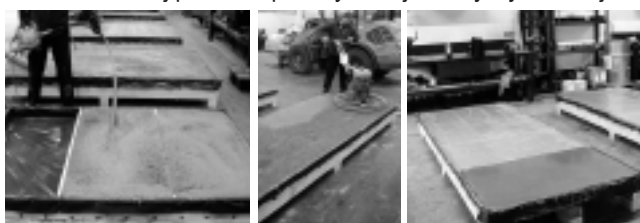
Wykonywanie posadzki w warunkach przemysłowych Fot. Autorzy
