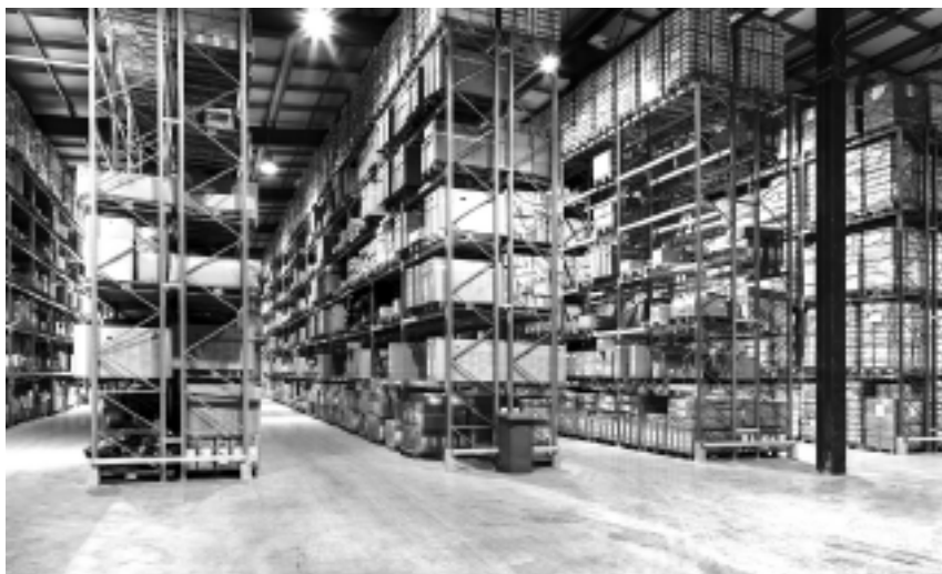
Posadzka w technologii FIBRON FL w obiekcie magazynowym [Fot. archiwum CEMEX Polska]
