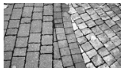
Fot. 2. Fragment nawierzchni z wibroprasowanej kostki brukowej wykonanej w technologii postarzania (z prawej i lewej) oraz standardowej (pośrodku)
