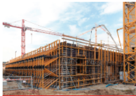
Deskowania firmy ULMA na budowie nowego bloku energetycznego w Elektrowni Kozienice [Fot. archiwum ULMA]
