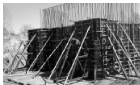
Widok montażu deskowania z rozmieszczeniem wsporników kozłowych
