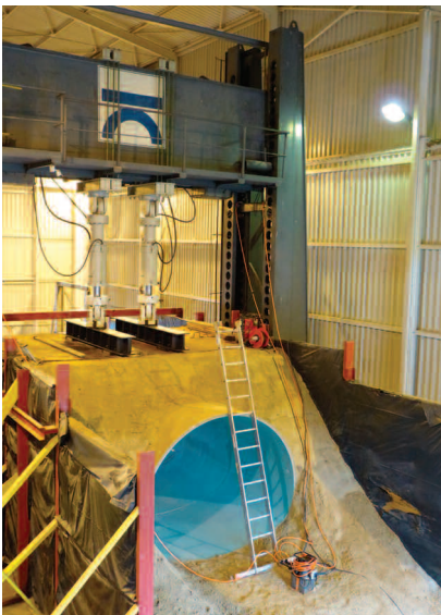
Fot. 3 Zabudowany model z konstrukcją przekazującą obciążenia
