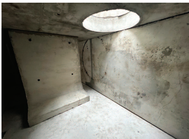
Fot. 3. Wnętrze zbiornika retencyjnego
