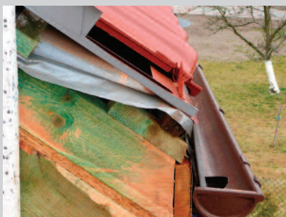
Fot. 2. Taki sam błąd, jak w przypadku dachu przedstawionego na fotografii 1. To co spływa po folii (MWK), jest zatrzymywane przez pas dorynnowy
