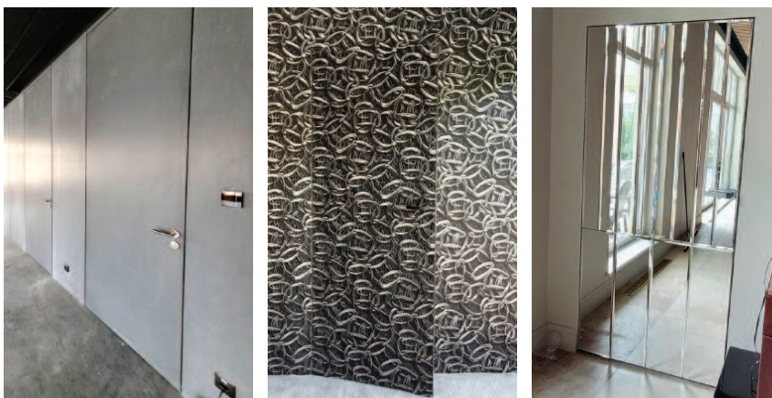
Fot. 2. Ościeżnice i drzwi z różnym wykończeniem, zbieżnym z wykończeniem ściany oraz ze zlicowanymi listwami przypodłogowymi
