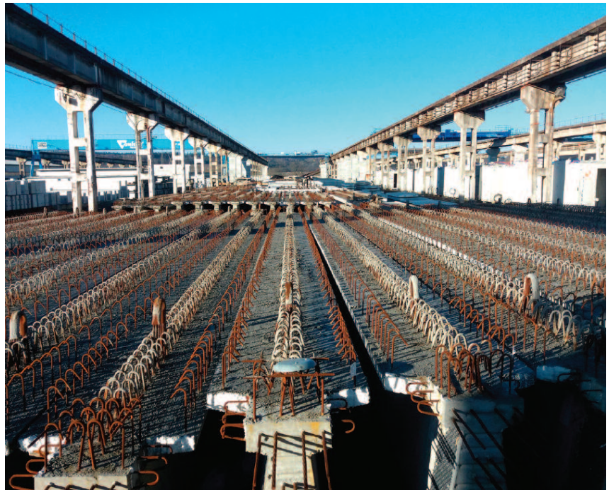
Belki prefabrykowane na placu składowym wytwórni
