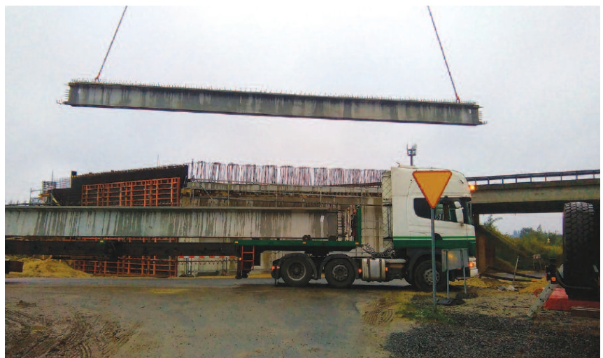
Montaż belki prefabrykowanej typu T
