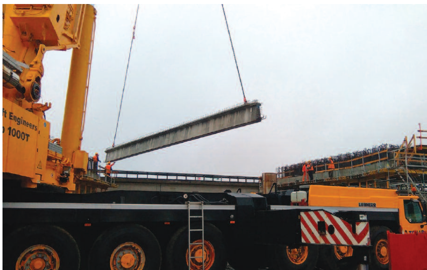
Ułożenie belki typu T na podporach
