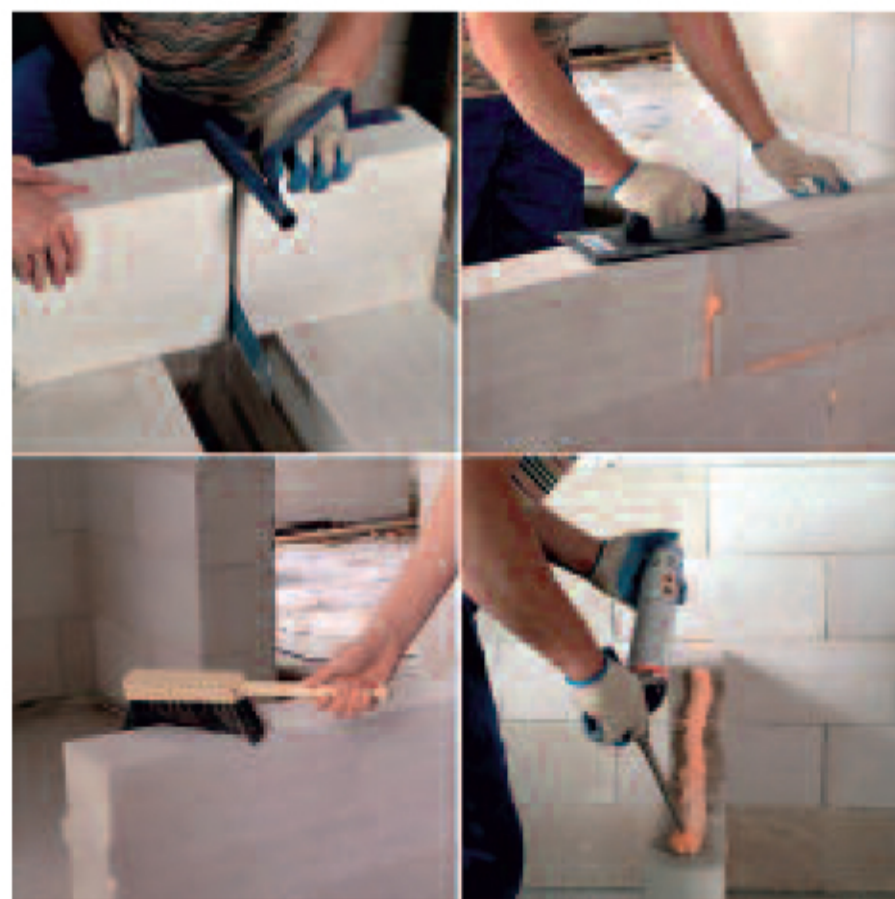
Fot. 3. Narzędzia potrzebne w trakcie wykonywania robót
