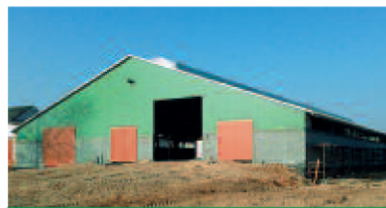
Fot. 3. Budynek inwentarski, w którym ściany wzniesiono z Pustaków Szalunkowych PS24
