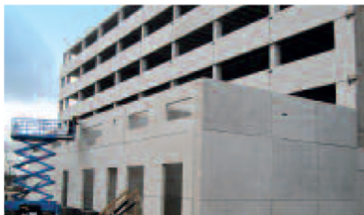
Fot. 1. Ściany prefabrykowane budynku biurowo-usługowego
