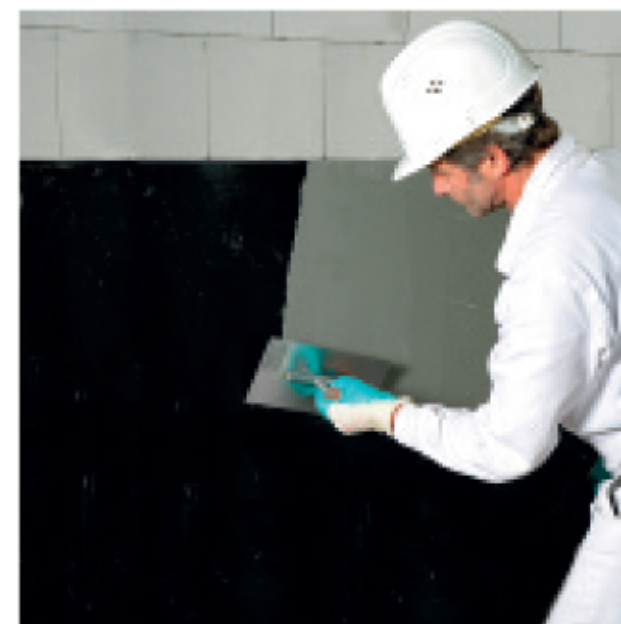
Nakładanie Multi-Baudicht 2K na starą izolację bitumiczną
