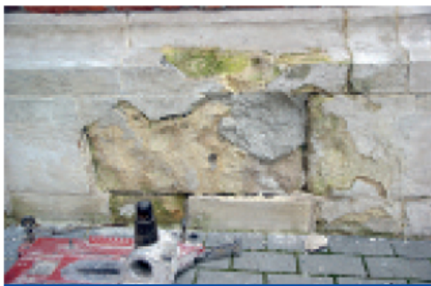
Fot. 3. Przykład wykonanej renowacji wątku kamiennego muru z wapienia, gdzie już po kilku miesiącach nastąpiły odspojenia flekowań oraz zaprawy, którą wykonano naprawy powierzchniowe
