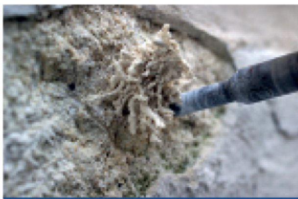
Fot. 4. Odwiert w murze – widoczne rolowanie silnie zawilgoconego kamienia wapiennego
