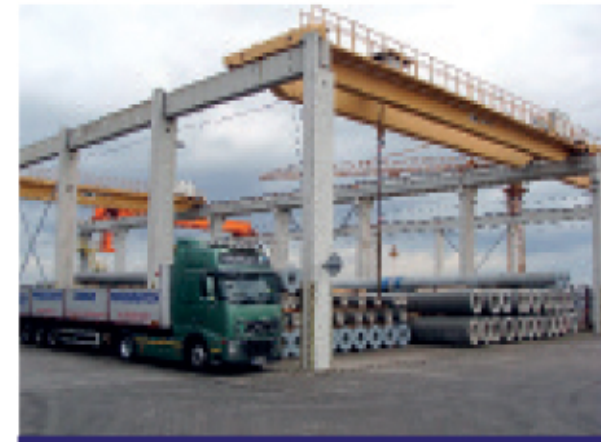
Fot. 3. Magazyn strunobetonowych wież wirowanych w Lewinie Brzeskim (2014 r.)
