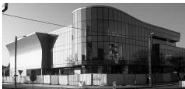
Fot. 2. Budynek Centrum Kulturalno-Artystycznego w Koziencicach, arch. Marcin Furtak
