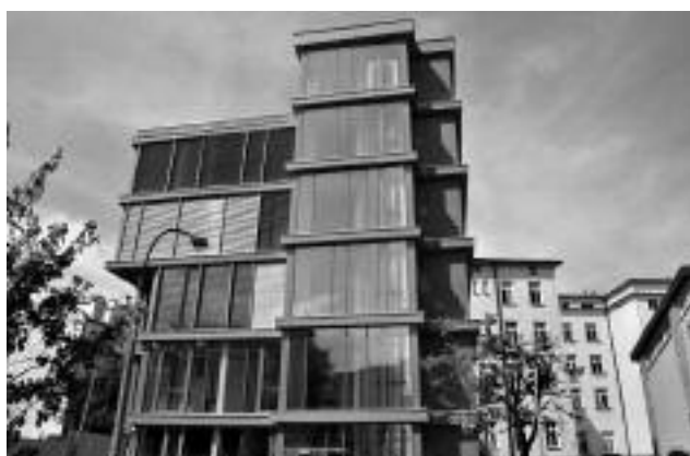
Fot. 3. Wykorzystanie elementów zacięniających w budynku Małopolskiego Laboratorium Budownictwa Energooszczędnego, arch. Marcin Furtak
