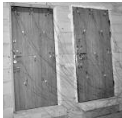
Fot 1. Drzwi stalowe, jednoskrzydłowe, płaszczowe, pełne, oklejone okładziną ozdobną Photo 1. Steel, single leaf doorsets covered with decorative facing
