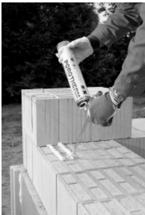
Wznoszenie ściany z pustaków Porotherm na zaprawie Porotherm Dryfix
