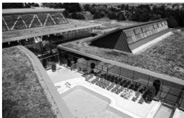
Dach ekstensywny o powierzchni 3 400 m 2 na parku wodnym w Filderstadt (Niemcy) [Fot. Optigruen]
