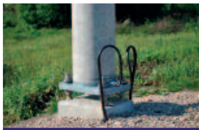
Fot. 7. Połączenie słupa ETG z palem fundamentowym Photo 7. ETG pole connection with the foundation pile
