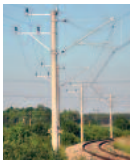
Fot. 6. Słupy ETG na łuku linii kolejowej Photo 6. ETG poles on the bow rail line
