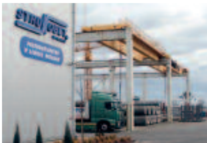
Fot. 2. Zakład w Lewinie Brzeskim – magazyn strunobetonowych wież telekomunikacyjnych
