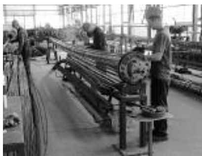
Fot. 1. Przygotowanie koszy zbrojarskich Photo 1. Preparation of reinforcing cage
