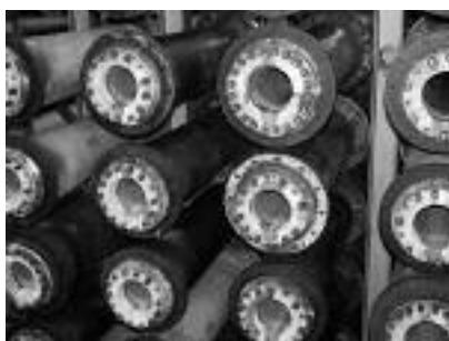
Fot. 4. Formy w komorze naparzalniczej Photo 4. Moulds in steam chamber
