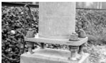
Fot. 3. Połączenie słupa ETG z fundamentem palowym
