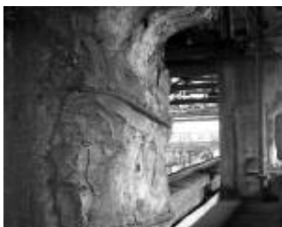
Fot. 2. Wycięcie fragmentu słupa w celu umożliwienia przejazdu suwnicy Photo 2. Removing of column fragment due to possibility of crane passing
