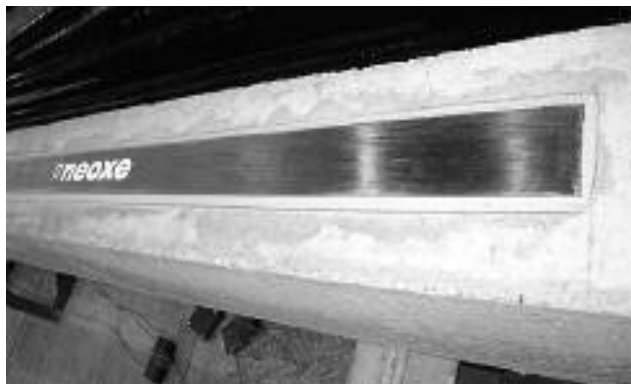
Fot. 1. Wzmocnienie belki przez doklejenie taśmy CFRP w strefie rozciąganej
