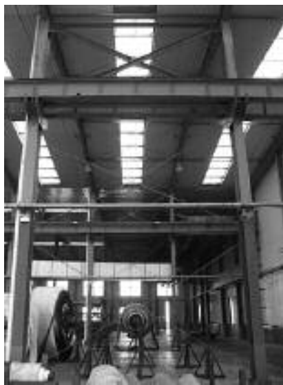
Fot. 4. Stężenia podłużne hali Photo 4. Longitudinal bracings of the hall
