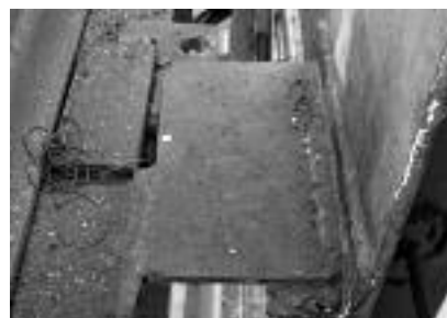
Fot. 3. Połączenie półki górnej belki podsownicowej ze słupem Photo 3. Upper flange of runaway beam – column joint
