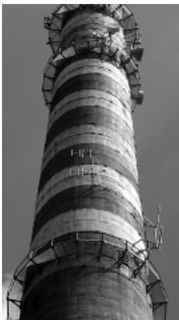
Fot. 2. Wzmocnienie kominia obręczami stalowymi
