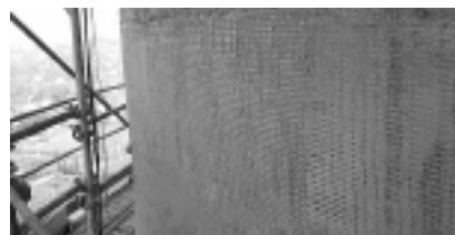
Fot. 4. Wzmocnienie kominia za pomocą mat mineralnych CFRP
