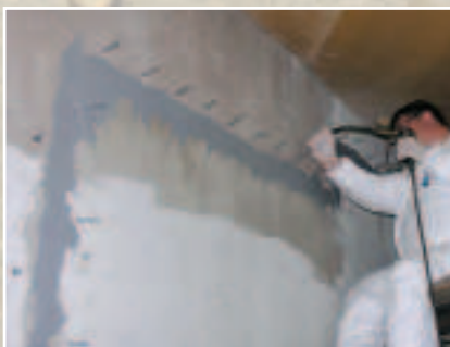
Tłoczenie środka WEBAC 1660 przez zamocowane iniektory w obszarze spękania
