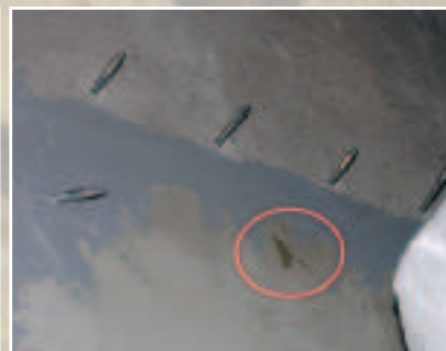
Typowy „śląd” potwierdzający zakres rozchodzenia się środka iniekcyjnego w murze
