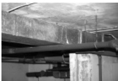
Fot. 2. Zniszczenia elementów ściany i stropów w wyniku wycieku wody przez dylatację Photo. 2. The damage parts of the walls and slabs due to the leakage of water through the expansion joint
