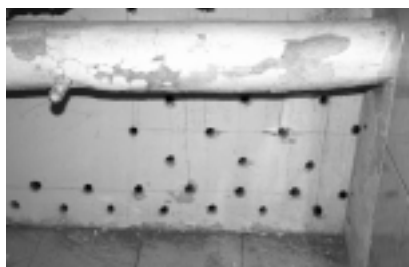
Fot. 1. Przygotowana siatka otworów Photo. 1. Prepared grid of holes
