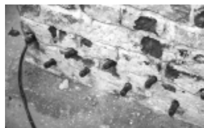
Fot. 3. Iniektory do ciśnieniowego podania substancji hydrofobizującej Photo. 3. Injection valves ready for pressure application of hydrophobic liquid
