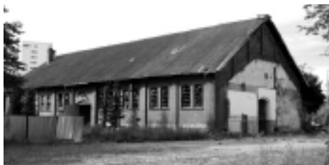
Fot. 1. Budynek ujeżdżalni koni (stan istniejący)
