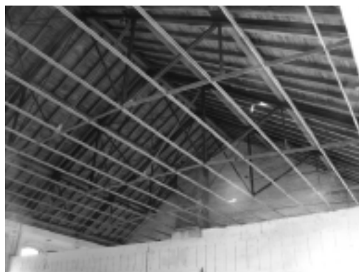
Fot. 2. Stalowe wiązary kratowe przekrycia budynku ujeżdżalni koni (stan istniejący)
