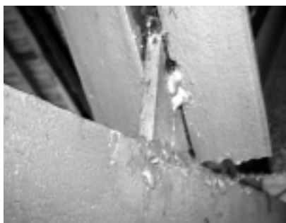
Fot. 3. Węzły konstrukcyjne stalowych wiązarów kratowych w miejscu połączenia prętów dodatkowych z istniejącą konstrukcją: połączenie słupka zewnętrznego z pasem dolnym
