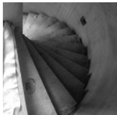
Fot. 6. Klatka schodowa
