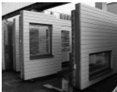
Fot. 3. Trójwarstwowe ściany zewnętrzne ze stolarką i pełnym wykończeniem
