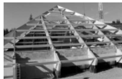
Widok konstrukcji dachu po montażu [archiwum własne]
