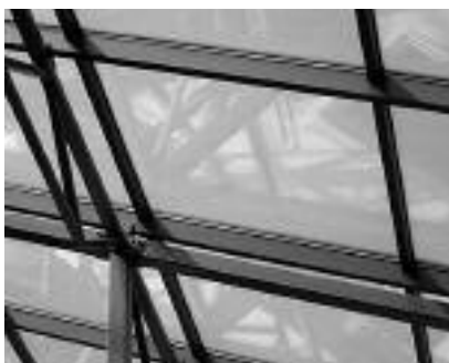
Fot. 1. Konstrukcja nośna szklanego przekrycia dachu
