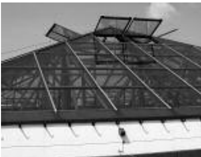
Fot. 2. Szklane przekrycie dachu w kształcie ostrosłupa
