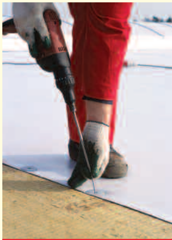
Mocowanie łącznikami folii PVC
