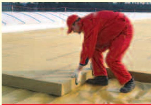
Układanie płyt ze skalnej wełny Rockwool na blasze trapezowej
