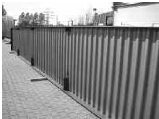
Fot. 1. Typowy dźwigar z falistym środkiem
