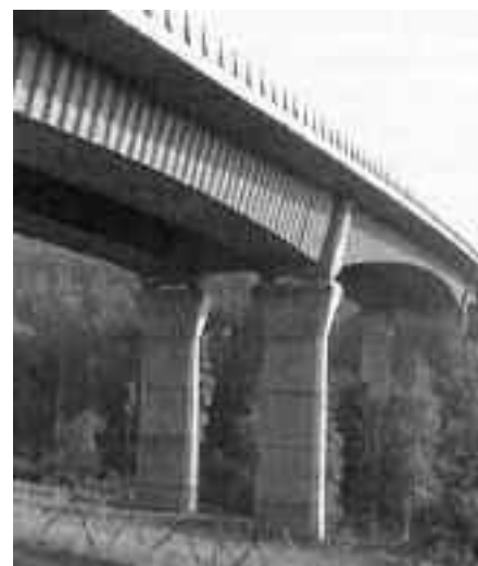
Fot. 3. Most nad doliną Altwipfergrund w Niemczech zbudowany z dźwigarów ze środnikiem falistym
