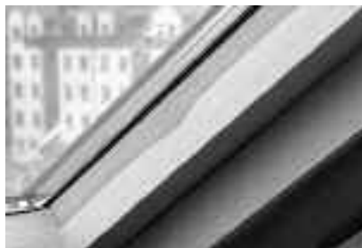
Fot. 3. Dwie listwy sklezione w ramiak, w tym jedna listwa jest jasna bielasta, a druga w przeważającej części ciemna twarde
