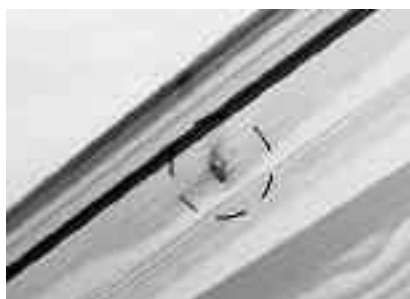
Fot. 8. Sęk skrzydlaty, zdrowy, mocno ciemny zgodnie z normą nie jest wadą, ale wizualnie psuje okno
