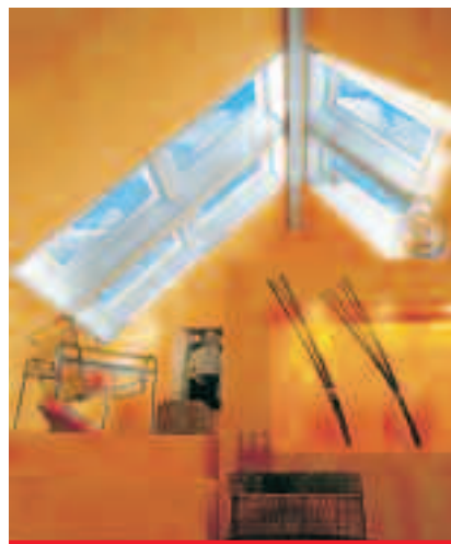
Fot. 1. Okna dachowe umieszczone w pobliżu kalenicy i zespolone za pomocą połączenia kalenicowego
