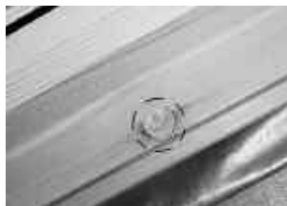
Fot. 9. Zaprawiony sęk na ramie ościeżnicy. Wstawka raczej nie harmonizuje z układem słoików, a ponadto wycięta jest z przekroju poprzecznego i powinna być wymieniona
