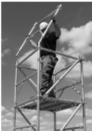
Fot. 1. Bezpieczny montaż systemu TG60
