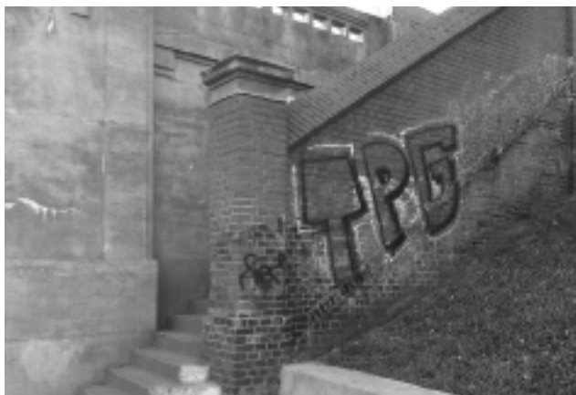
Fot. 4. Zejście z mostu (kwiecień 2014 r.)
