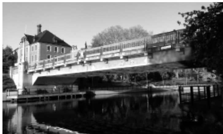
Fot. 2. Stan aktualny mostu Królowej Jadwigi, kwiecień 2014
