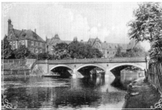
Fot. 1. Ceglany most Królowej Jadwigi wybudowany w latach 1861 – 1865
